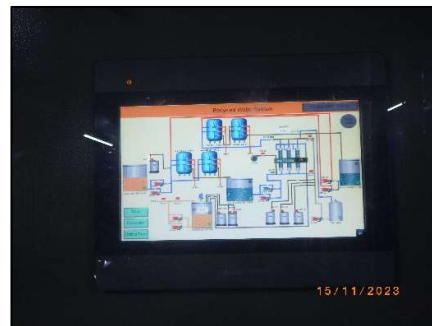
รูปที่ 2-16 ระบบปรับปรุงคุณภาพน้ำ
