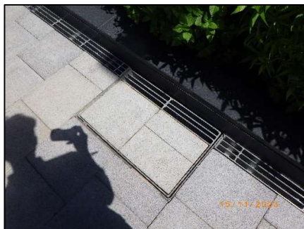
ตะแกรงครอบท่อระบายน้ำทั้งภายนอกอาคาร
