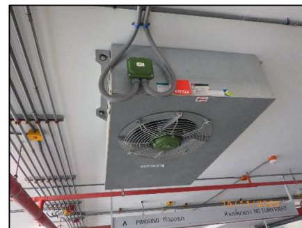
รูปที่ 2-9 พัดลมระบายอากาศ อาคารจอดรถ
