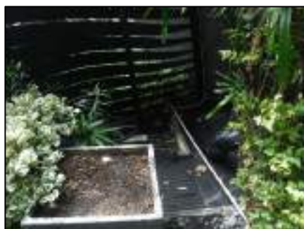
บ่อกักน้ำสุดท้ายของระบบระบายน้ำของโครงการก่อนระบายลงสู่ระบบระบายน้ำบริเวณด้านหน้าโครงการ
