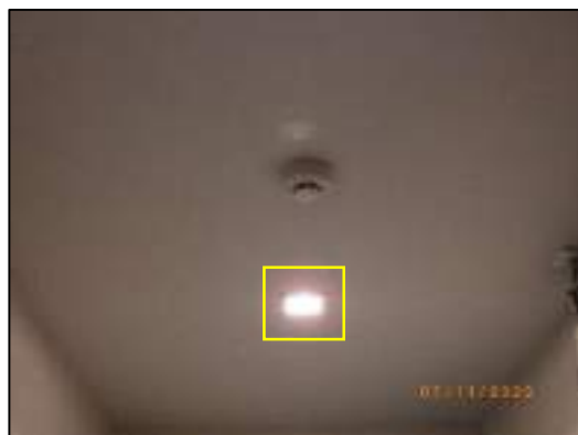
รูปที่ 2-52 โคมไฟพื้นที่ส่วนกลางแบบมีแผ่นสะท้อน
