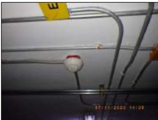
รูปที่ 2-31 ระบบดับเพลิงอัตโนมัติ
