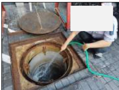
รูปที่ 2-21 การตรวจสอบและการทำความสะอาดบ่อพักน้ำ
