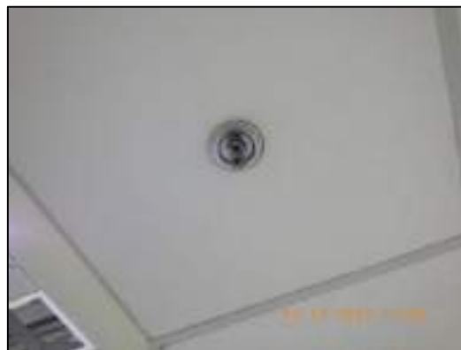
รูปที่ 2-31 ระบบดับเพลิงอัตโนมัติ
