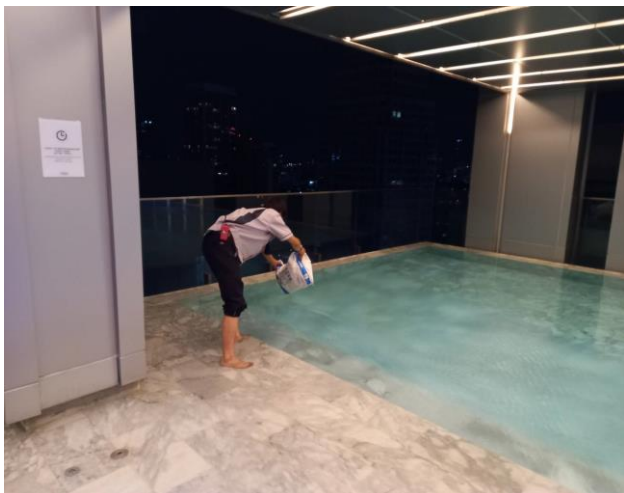
ช่างอาคารฯ เติมเกลือสระว่างน้ำ ชั้น 27 ตามแผนงาน
