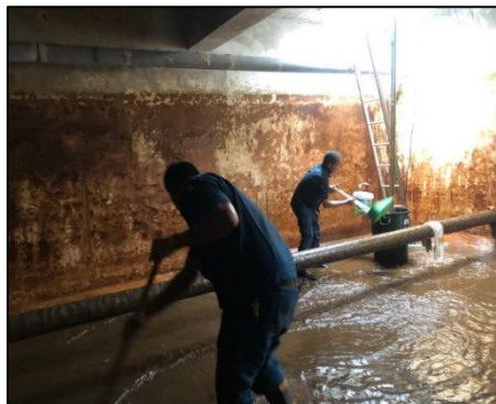
รูปที่ 3.3 ล้างทำความสะอาดถังสำรองน้ำใช้
