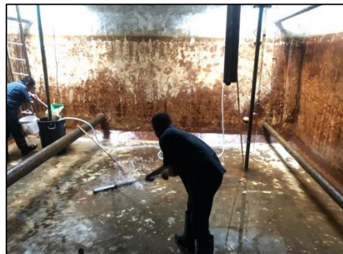
รูปที่ 3.3 ล้างทำความสะอาดถังสำรองน้ำใช้
