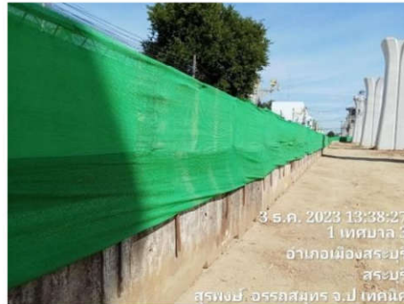
ภาพที่ 2.2-35 การติดผ้าใบกันฝุ่น
