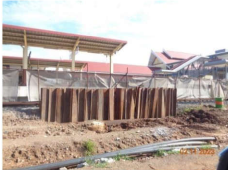
ภาพที่ 2.2-51 การปัก Sheet pile กันดินพังทลาย
