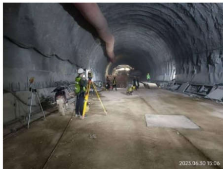
ภาพที่ 3.2.1-1 การตรวจวัดการทรุดตัวจากกิจกรรมการก่อสร้างอุโมงค์
