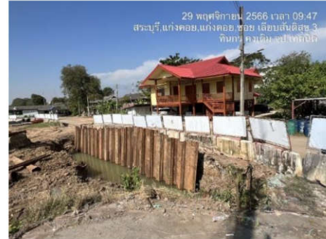
ภาพที่ 2.2-51 การปัก Sheet pile กันดินพังทลาย
