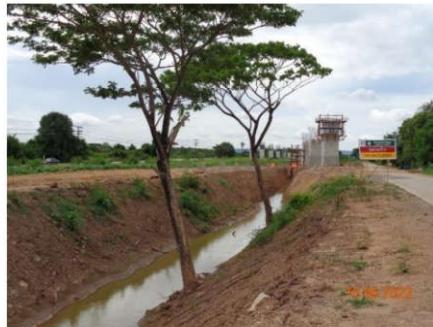
ภาพที่ 2.2-28 ทางเบี่ยงน้ำจากทางระบายน้ำเดิม
