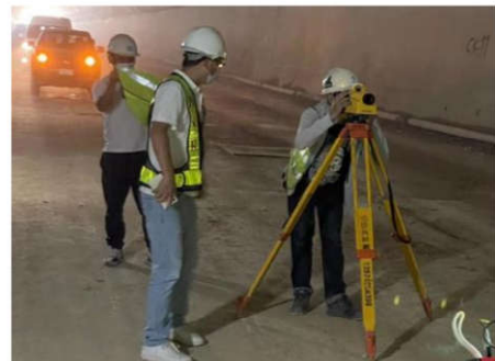
ภาพที่ 3.2.1-1 การตรวจวัดการทรุดตัวจากกิจกรรมการก่อสร้างอุโมงค์
