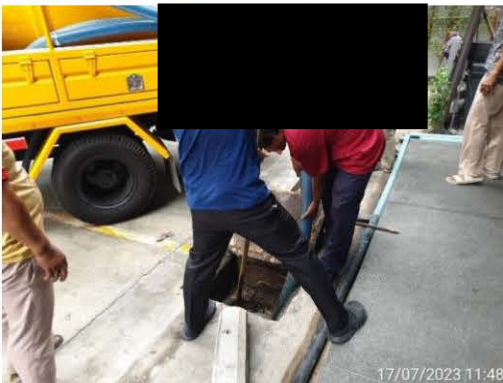
การสูบน้ำมัน และตะกอนระบบบำบัดน้ำเสีย
