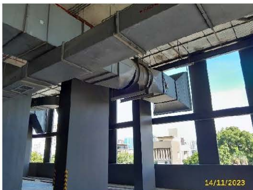
ระบบอัดอากาศบริเวณโถงลิฟต์ดับเพลิง
