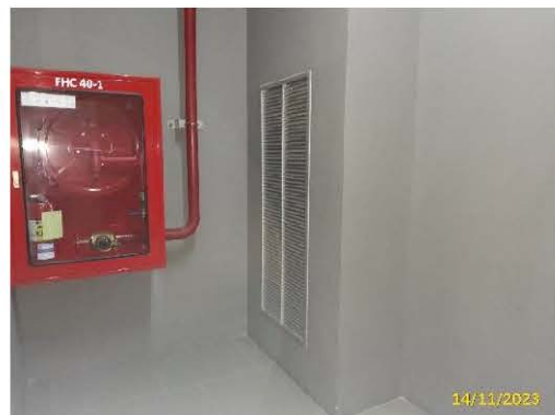
ระบบอัดอากาศบริเวณโถงลิฟต์ดับเพลิง
