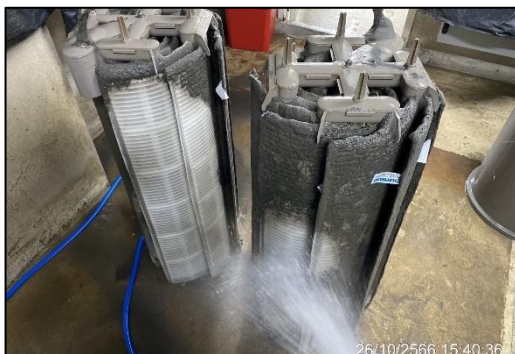
รูปที่ 2-46 การทำความสะอาดเครื่องกรองน้ำของสระว่ายน้ำ
