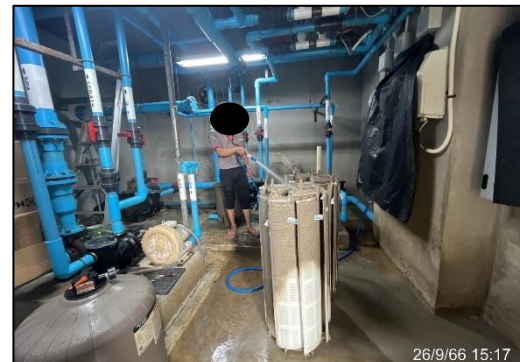
รูปที่ 2-46 การทำความสะอาดเครื่องกรองน้ำของสระว่ายน้ำ
