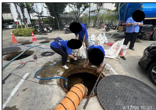
รูปที่ 2-36 การสูบลบตะกอนในบ่อเกรอะ
