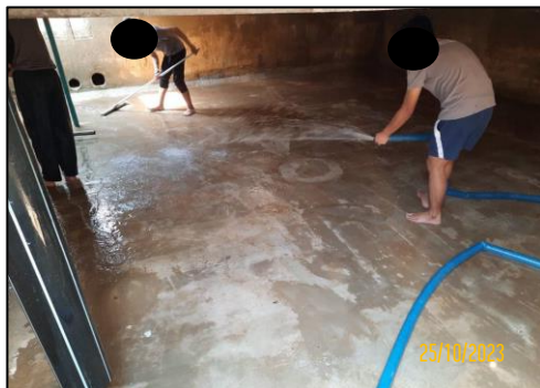
รูปที่ 2-30 การทำความสะอาดถังเก็บน้ำสำรอง
