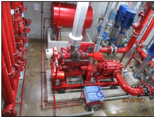
รูปที่ 2-49 เครื่องสูบน้ำดับเพลิง
