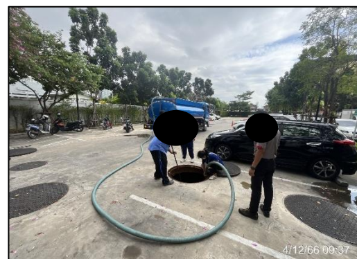
รูปที่ 2-36 การสูบลบตะกอนในบ่อเกรอะ
