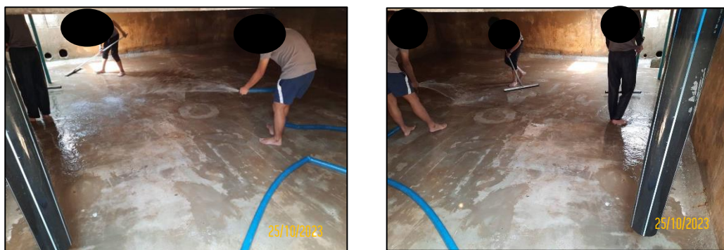
รูปที่ 3-28 การตรวจสอบและทำความสะอาดถังสำรองน้ำใช้
