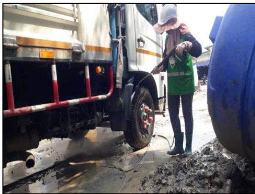
รูปที่ 98 พื้นที่ล้างล้อรถและคนงานฉีดล้างล้อรถ
