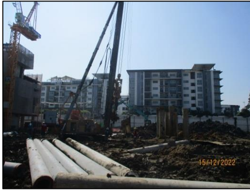
รูปที่ 32 (ต่อ) เส้าเข็มกด Jack In Pile
