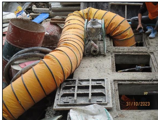
รูปที่ 105 การใช้พัดลมดูดอากาศ ขณะปฏิบัติงานในพื้นที่อับชื้น
