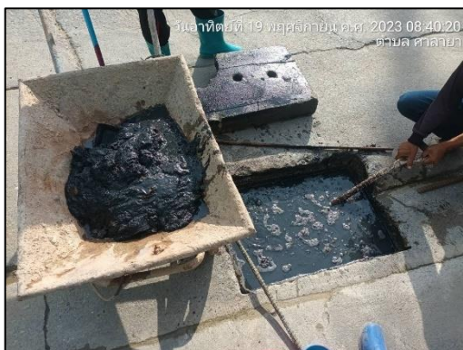
รูปที่ 47 คนงานขุดลอกท่อระบายน้ำสาธารณะบริเวณด้านหน้าโครงการ
