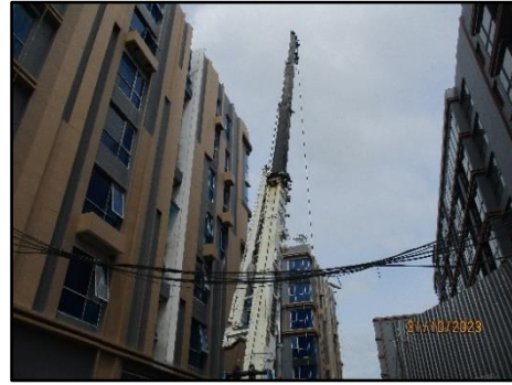
รูปที่ 88 เครนเป็นแบบพับแขนได้และแขนของเครนอยู่ภายในพื้นที่โครงการ
