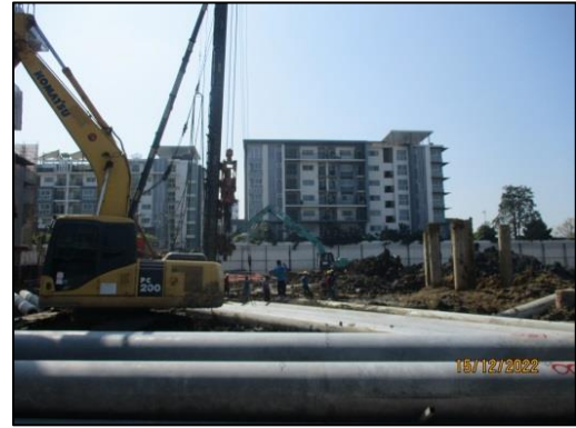
รูปที่ 32 (ต่อ) เส้าเข็มกด Jack In Pile
