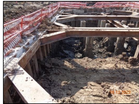
รูปที่ 10 ระบบป้องกันดินพังโดยใช้ Sheet Pile ในบริเวณที่ขุดดินลึก
