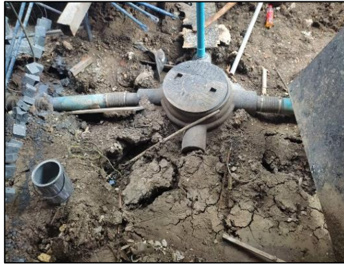
รูปที่ 35 ระบบบำบัดน้ำเสียสำเร็จรูปชั่วคราว
