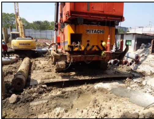
รูปที่ 92 วัสดุป้องกันการสั่นสะเทือนรองไว้ใต้เครื่องจักร
