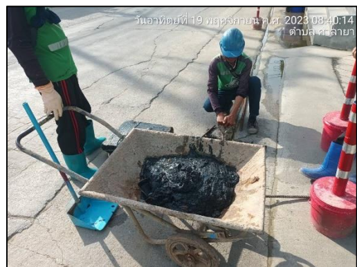
รูปที่ 47 คนงานขุดลอกท่อระบายน้ำสาธารณะบริเวณด้านหน้าโครงการ
