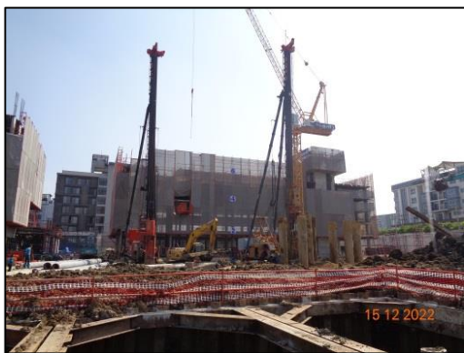
รูปที่ 32 เส้าเข็มกด Jack In Pile
