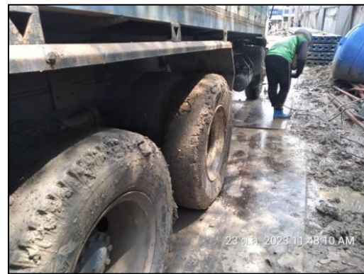
รูปที่ 98 พื้นที่ล้างล้อรถและคนงานฉีดล้างล้อรถ
