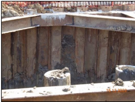
รูปที่ 10 ระบบป้องกันดินพังโดยใช้ Sheet Pile ในบริเวณที่ขุดดินลึก
