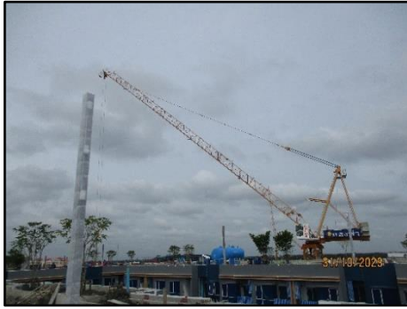
รูปที่ 88 เครนเป็นแบบพับแขนได้และแขนของเครนอยู่ภายในพื้นที่โครงการ
