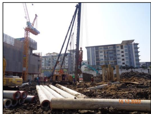
รูปที่ 32 เส้าเข็มกด Jack In Pile
