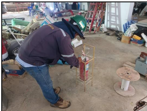
รูปที่ 85 การตรวจสอบถังดับเพลิงแบบมือถือ
