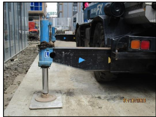
รูปที่ 92 วัสดุป้องกันการสั่นสะเทือนรองไว้ใต้เครื่องจักร
