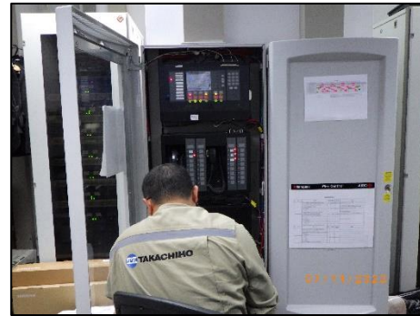
รูปที่ 2-13 การตรวจสอบอุปกรณ์และระบบป้องกันอัคคีภัย
