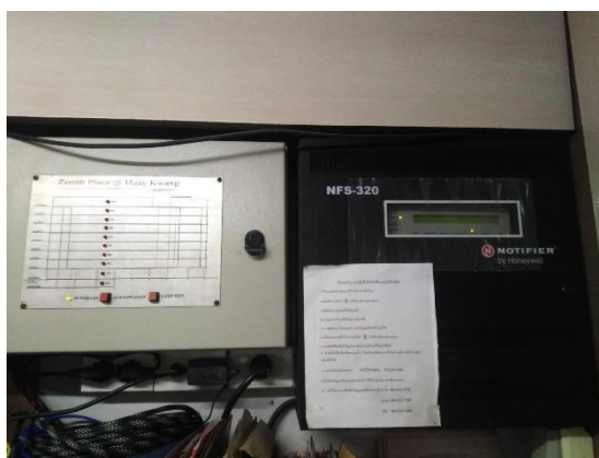
รูปที่ 41 ตู้ควบคุมระบบแจ้งเหตุเพลิงไหม้
