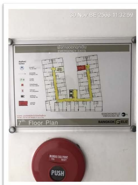
เครื่องแจ้งเหตุเพลิงไหม้ใช้มือ และ กริ่งเตือนภัย
