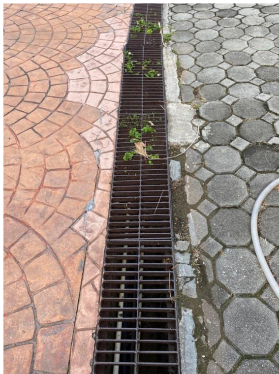
ภาพที่ 6 แสดงรางระบายน้ำภายนอกอาคารและตะแกรงดักขยะ
