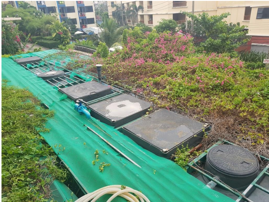
ภาพที่ 31 แสดงระบบบำบัดน้ำเสียของโครงการ 80 ลบ.ม.
