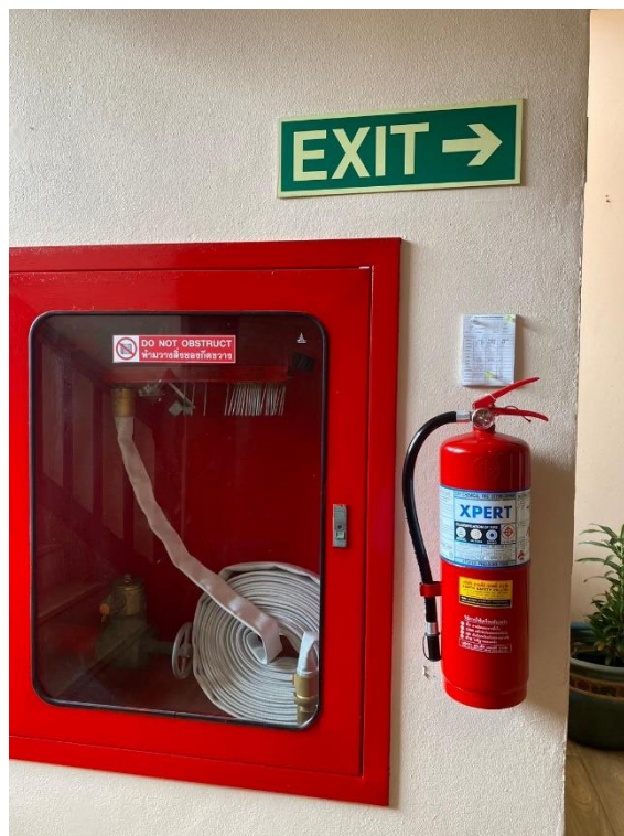
ภาพที่ 34 แสดงตู้เก็บสายน้ำดับเพลิง
