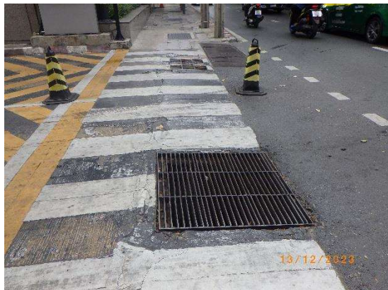
รูปที่ 2-27 ตะแกรงดักมูลฝอยจุดน้ำออก บริเวณทางออกโครงการฯ ฟังถนนวิทย์
