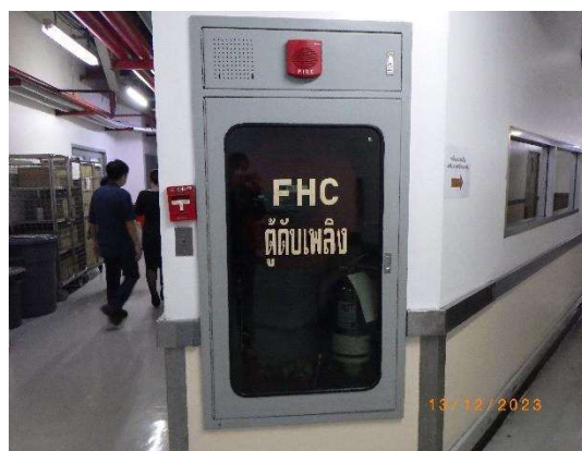
รูปที่ 2-34 ตู้เก็บอุปกรณ์ดับเพลิง
