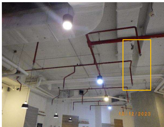
รูปที่ 2-45 ระบบหัวกระจายน้ำดับเพลิงภายในอาคาร
