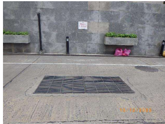
รูปที่ 2-26 ตะแกรงดักมูลฝอยจุดน้ำออก บริเวณทางเข้าโครงการฯ ฟังถนนวิทย์
