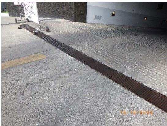
รูปที่ 2-31 รางระบายน้ำภายในพื้นที่โครงการฯ
