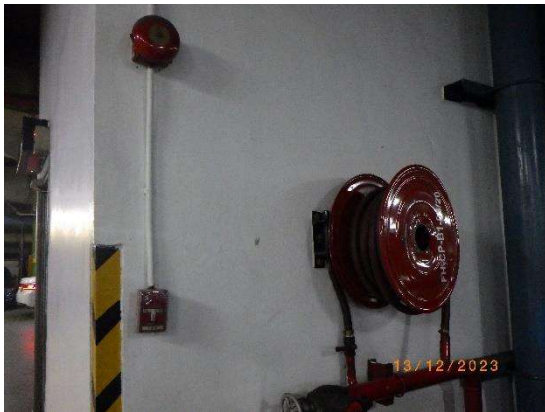
รูปที่ 2-37 ระบบหัวฉีดน้ำดับเพลิงภายในตัวอาคาร
