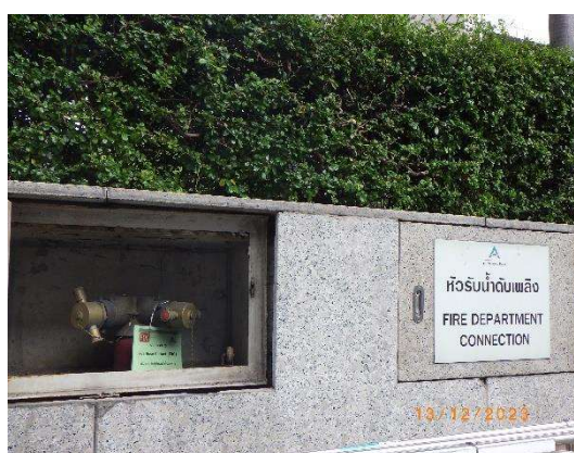
รูปที่ 2-36 ตู้เก็บหัวรับน้ำดับเพลิง
