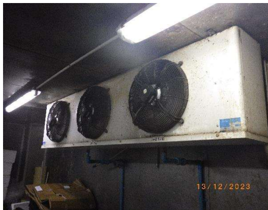
รูปที่ 2-19 ติดตั้งเครื่องปรับอากาศภายใน ห้องพักรถยนต์
