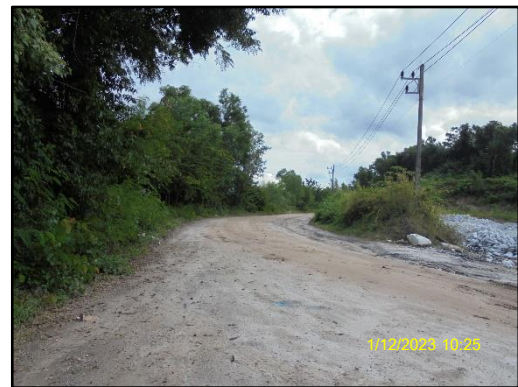
ภาพที่ 2.6 สภาพเส้นทางลำเลียงแร่ที่ปรับแต่งผิวถนนและบดอัดแน่น
