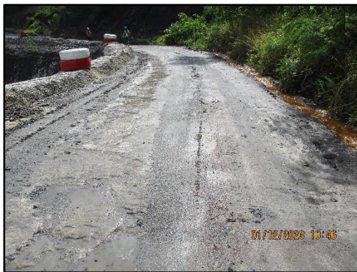
ภาพที่ 2.6 สภาพเส้นทางลำเลียงแร่ที่ปรับแต่งผิวถนนและบดอัดแน่น
