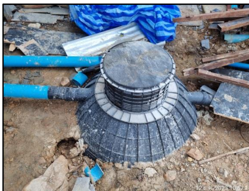
รูปที่ 1-8 ระบบบำบัดน้ำเสีย บริเวณพื้นที่ก่อสร้างโครงการ
