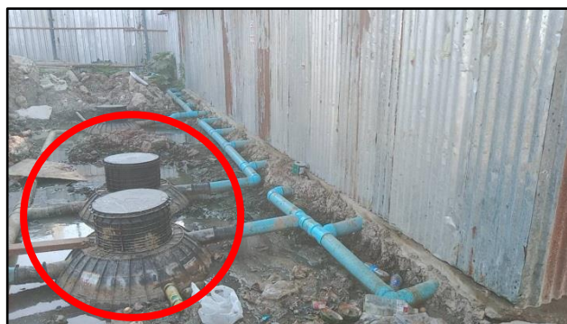
รูปที่ 1-9 ระบบบำบัดน้ำเสีย บริเวณบ้านพักคนงาน
