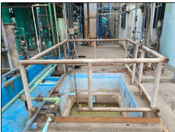
รูปที่ 31 บ่อรองรับน้ำทิ้งที่ผ่านการบำบัดแล้ว
