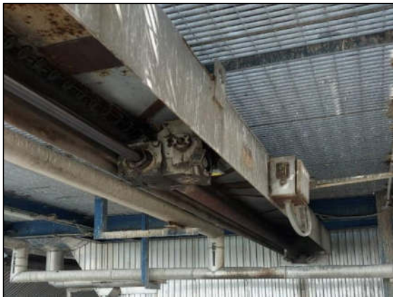
รูปที่ 4 เครื่องเป่าเขม่า (Soot Blow)
