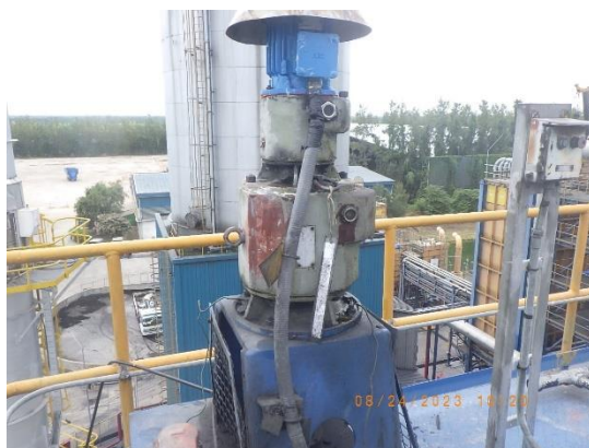
Picture 86 : DE rapping motor
