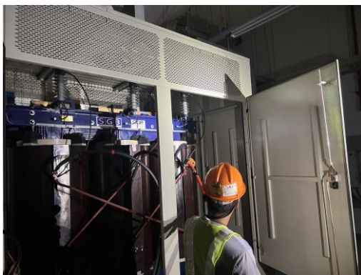
เจ้าหน้าที่ตรวจสอบหม้อแปลงไฟฟ้า
