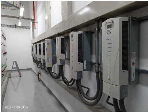
ระบบ VSD ของระบบปรับอากาศ
