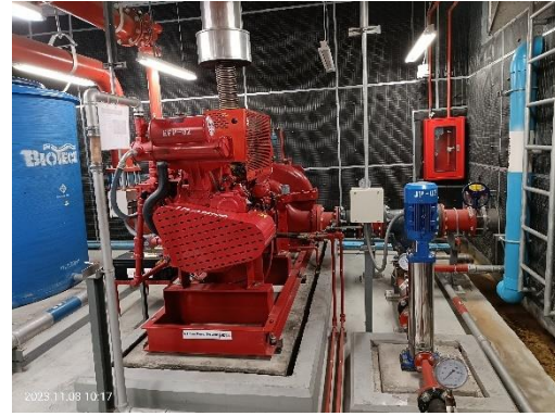
Fire Pump & Jockey Pump ชั้น 11 M
