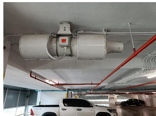
พัดลมช่วยระบายอากาศด้วยระบบตรวจวัด CO
