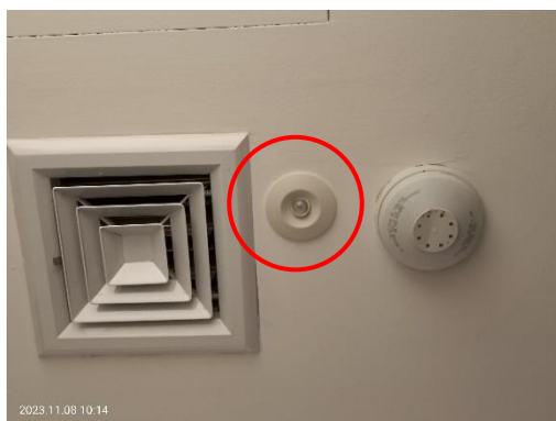
Movement Sensor ภายในห้องน้ำ
