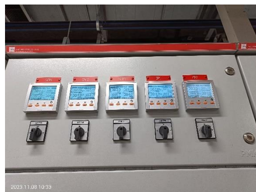
มิเตอร์ไฟฟ้าแยกเฉพาะระบบบำบัดน้ำเสีย
