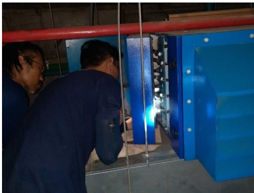
ตรวจสอบระบบ UV ที่ดูดอากาศจากระบบบำบัดน้ำเสีย
