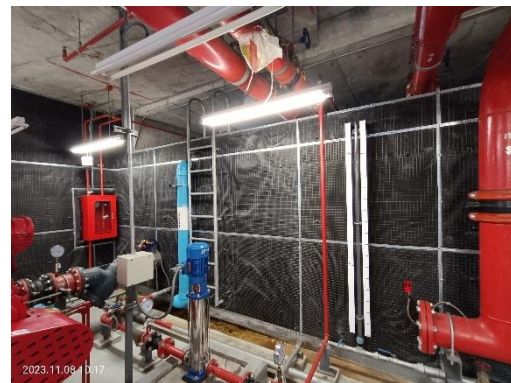
ถังเก็บน้ำดับเพลิง ชั้น 11M จำนวน 2 ถัง
