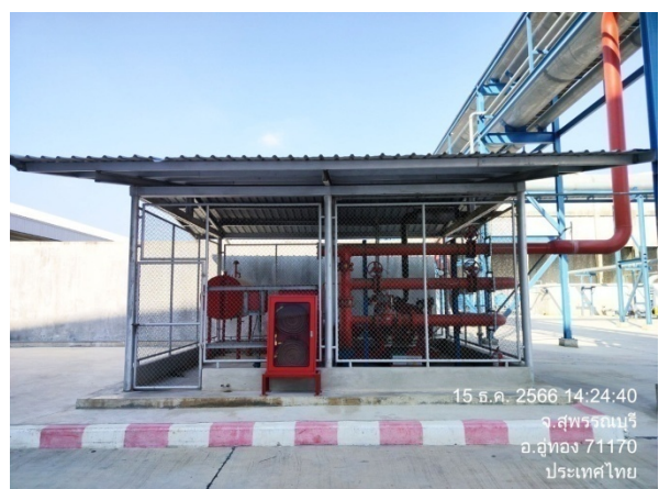
รูปที่ 2-51 เครื่องสูบน้ำดับเพลิง (Fire pump)
