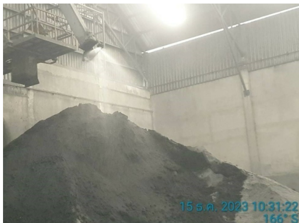
รูปที่ 2-15 ระบบฉีดพรมภายในอาคารเก็บถั่ว
