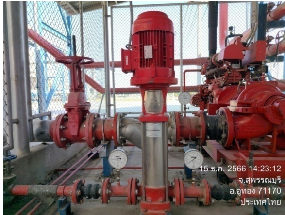
รูปที่ 2-52 เครื่องสูบน้ำแรงดัน (Jockey pump)
