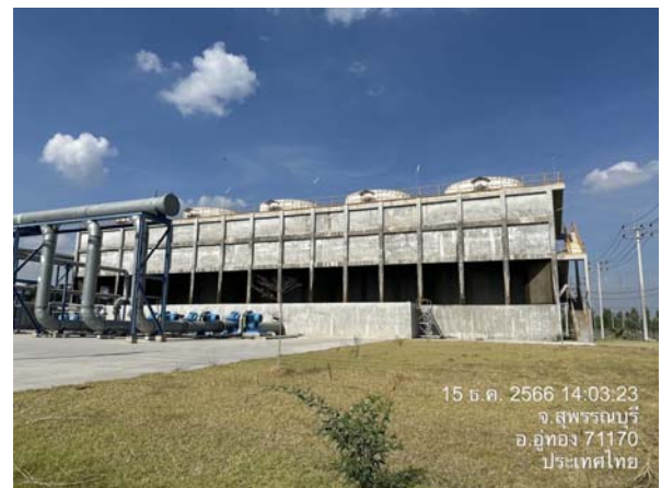
6. หอหล่อเย็น (Cooling Tower)
