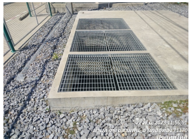
รูปที่ 2-16 ระบบแยกน้ำมัน (Oil Separator)
