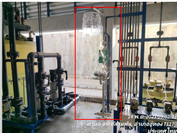
รูปที่ 2-40 อ่างล้างตาฉุกเฉิน และฝักบัวฉุกเฉิน
