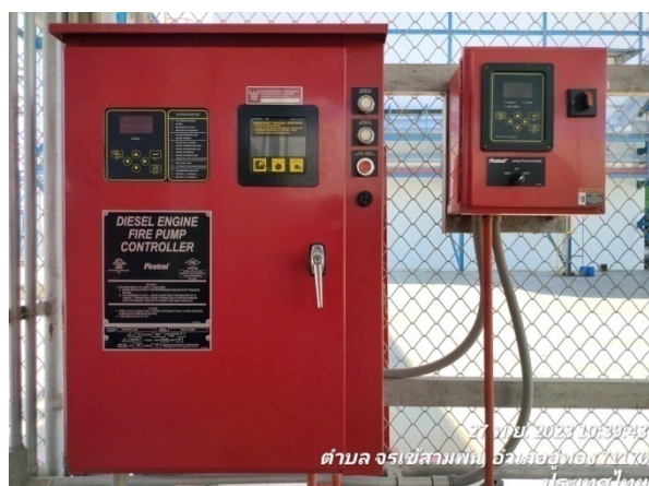
รูปที่ 2-51 เครื่องสูบน้ำดับเพลิง (Fire pump)
