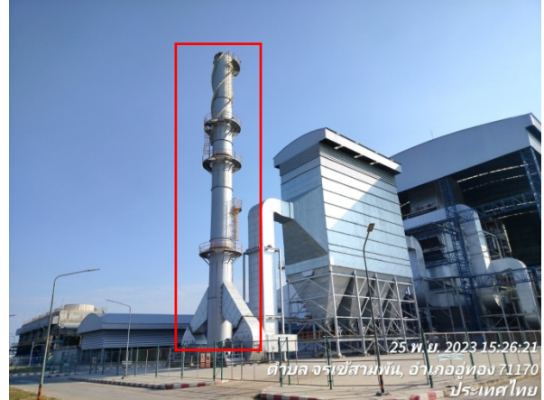
รูปที่ 2-6 ปล่องระบายอากาศหม้อไอน้ำ
