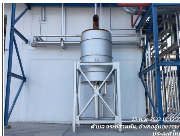
รูปที่ 2-9 อุปกรณ์ป้องกันเสียงดัง (Silencer)
