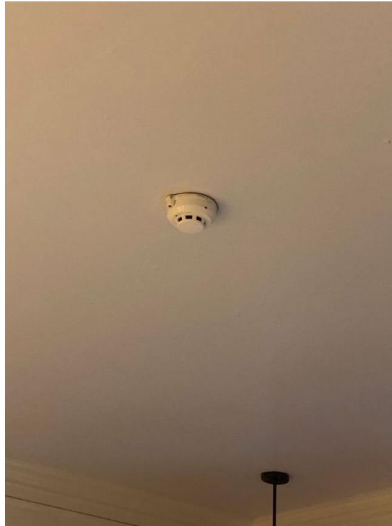
ภาพที่ 3 แสดง Smoke Detector ภายในห้องพัก
