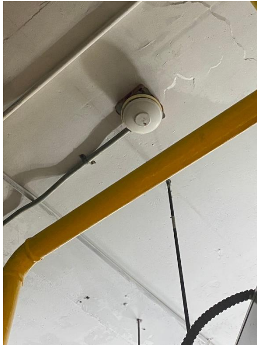
ภาพที่ 19 แสดง Heat Detector ภายในห้องครัว
