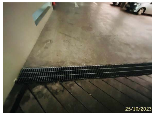
ตะแกรงดักขยะบริเวณบ่อพักน้ำสุดท้ายก่อนระบบออกนอกโครงการ
