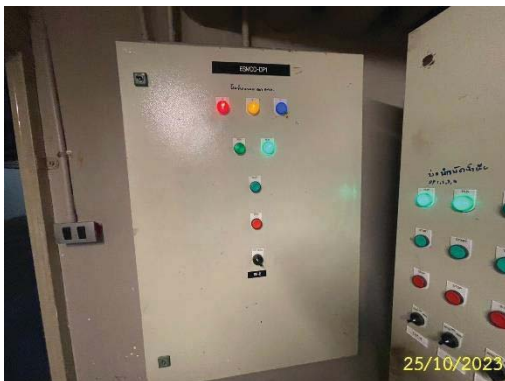
ตู้ควบคุมอัตราการระบายน้ำออกจากโครงการ
