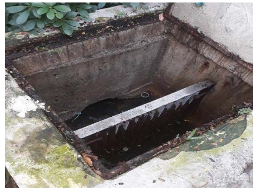
ตะแกรงดักขยะบริเวณบ่อพักน้ำสุดท้ายก่อนระบบออกนอกโครงการ
