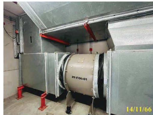
ระบบระบายอากาศที่จอดรถชั้นใต้ดิน
