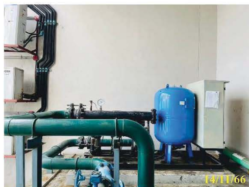
ถังเก็บน้ำชั้นดาดฟ้า พร้อม Booster pump
