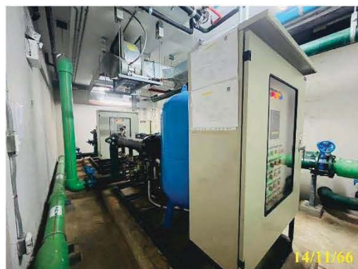
ถังเก็บน้ำชั้น 25 พร้อม Booster pump
