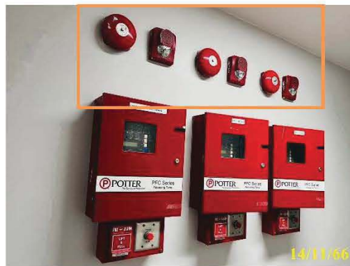
กริ่งสัญญาณเตือนภัย (Fire Alarm Speaker)
