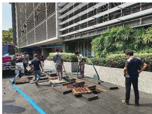
สูบละกอน และกากไขมันระบบบำบัดน้ำเสีย (04/02/66)
