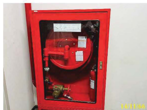
เก็บสายฉีดน้ำดับเพลิงพร้อมอุปกรณ์ (FHC)
