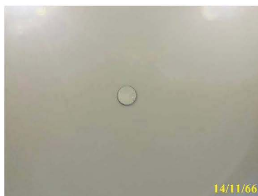
ระบบหัวกระจายน้ำดับเพลิงอัตโนมัติ (แบบปิด)
