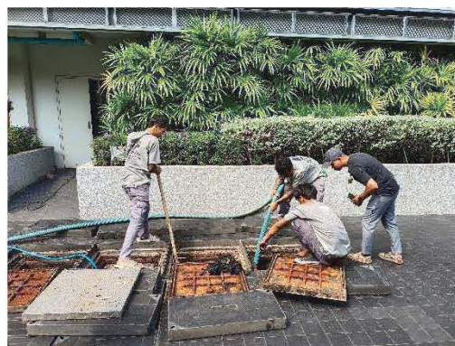
สูบละกอน และกากไขมันระบบบำบัดน้ำเสีย (04/02/66)
