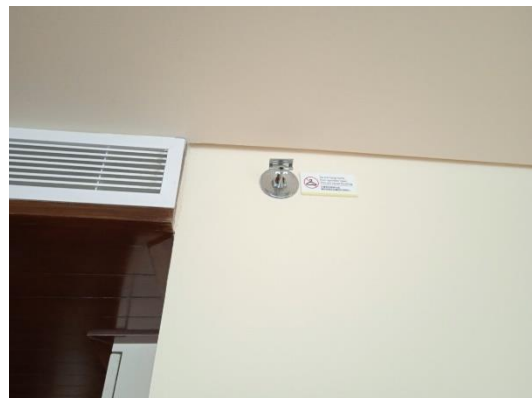
ภาพที่ 14 สปริงเกอร์ชนิดน้ำดับเพลิง
