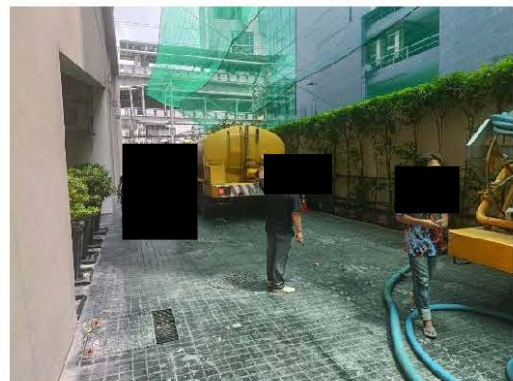
การสูบน้ำมัน/ตะกอนระบบบำบัด
