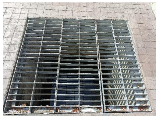
ตะแกรงดักขยะ ในบ่อพักน้ำสุดท้าย ก่อนปล่อยออกสู่โครงการ
