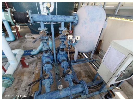
ปั๊มสูบน้ำชั้นหลังคา อาคารละ 1 ชุด
