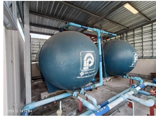
ถังเก็บน้ำชั้นหลังคาอาคารละ 2 ถัง
