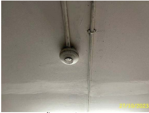
หัวกระจายน้ำและเครื่องตรวจจับความร้อน
