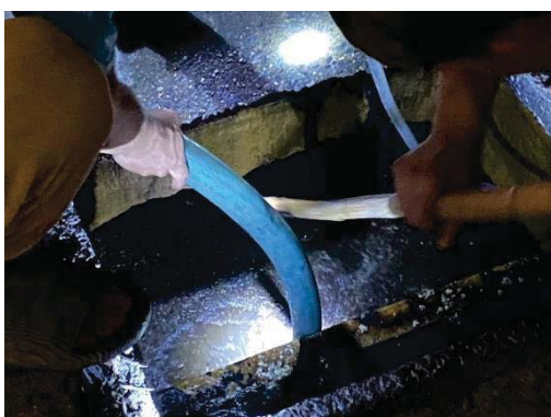
สูบล้างส่วนเกินและสูบล้างไขมันออกจากระบบบำบัดน้ำเสีย
