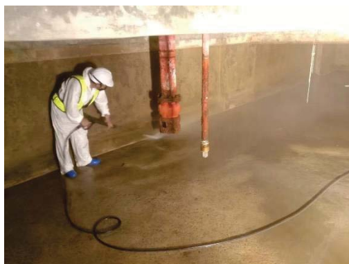
การทำความสะอาดถังเก็บน้ำ ภาพที่ 2.2-9 (ต่อ) ระบบน้ำใช้
