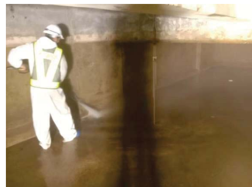
การทำความสะอาดถังเก็บน้ำ ภาพที่ 2.2-9 (ต่อ) ระบบน้ำใช้
