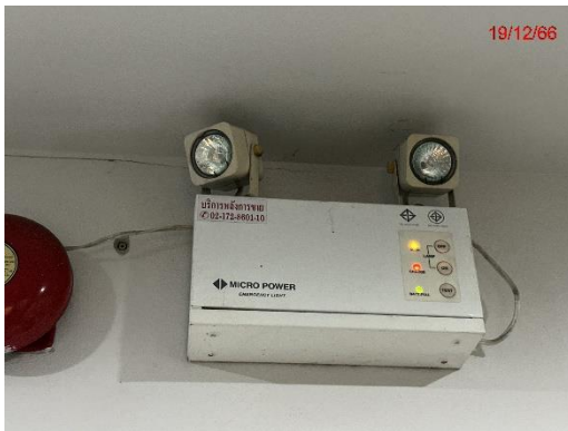
ภาพที่ 2.2-15 ระบบไฟฟ้าส่องสว่างฉุกเฉิน
