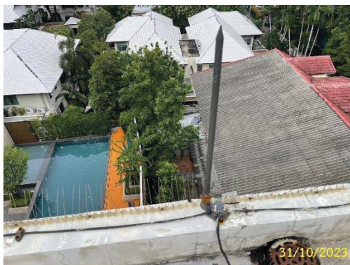
ภาพที่ 1.3.11-1 ระบบป้องกันอันตรายจากฟ้าผ่า
