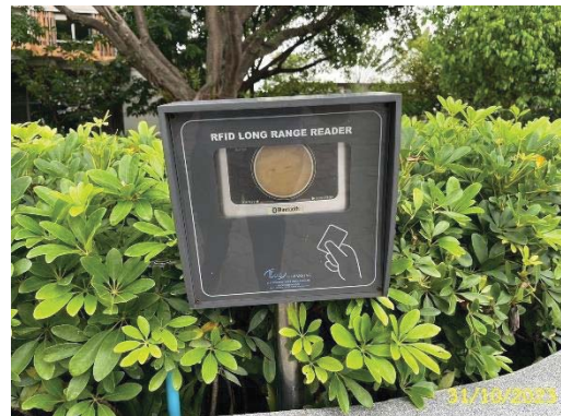
ระบบบัตรควบคุมการเข้า-ออกโครงการ
