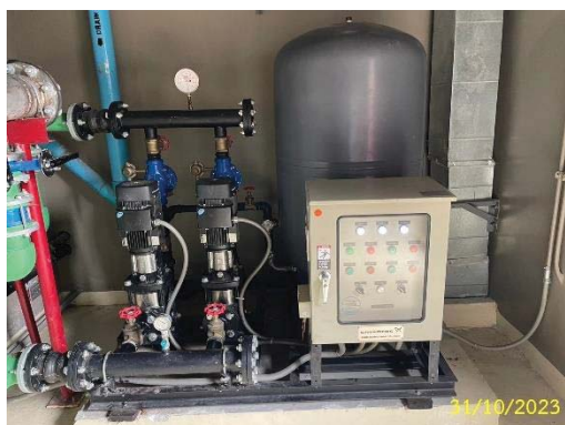
ระบบจ่ายน้ำขึ้นหลังคาอาคาร A
