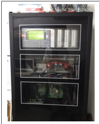
แผงควบคุม Fire Alarm
