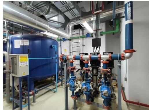
เครื่องสูบน้ำ Reuse
