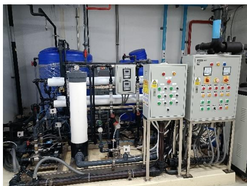
ระบบปรับปรุงคุณภาพน้ำสำหรับระบบปรับอากาศ
