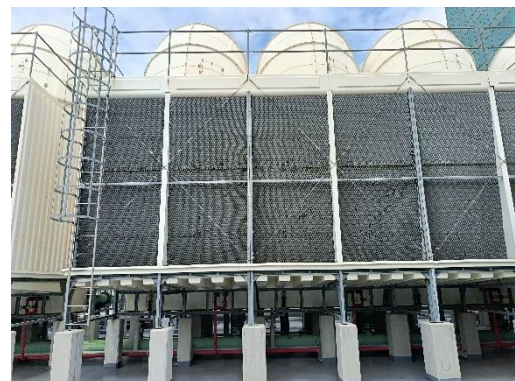
อุปกรณ์กำจัดละอองปลิว (Drift Eliminator)
