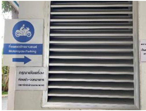
ช่องเปิดระบายอากาศบันไดหนีไฟ
