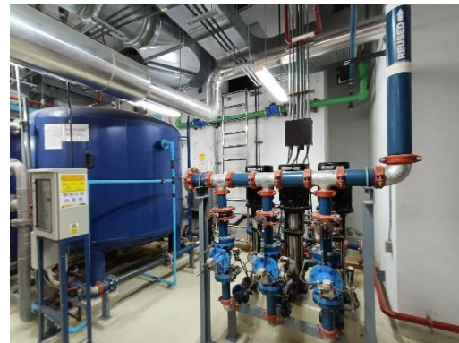
เครื่องสูบน้ำ Reuse
