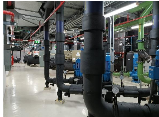
ระบบปรับอากาศชนิดเครื่องจักรทำความเย็นแบบรวมศูนย์ระบายความร้อนด้วยน้ำ
