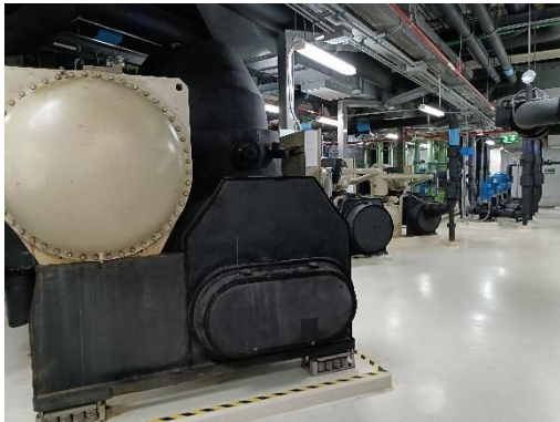
ระบบปรับอากาศชนิดเครื่องจักรทำความเย็นแบบรวมศูนย์ระบายความร้อนด้วยน้ำ
