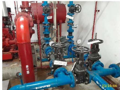
ถังเก็บน้ำ พร้อมเครื่องปั้มน้ำขึ้นใต้ดิน อาคาร B
