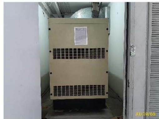
เครื่องกำเนิดไฟฟ้าฉุกเฉิน (Generator)
