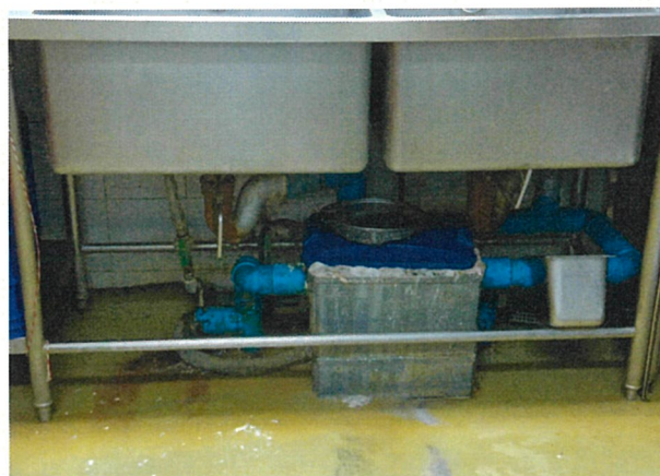
รูปที่ 2.2 ถังดักไขมันใต้อ่างล้างจาน
