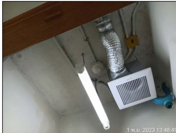
รูปที่ 2.28 เครื่องตรวจจับความร้อน
