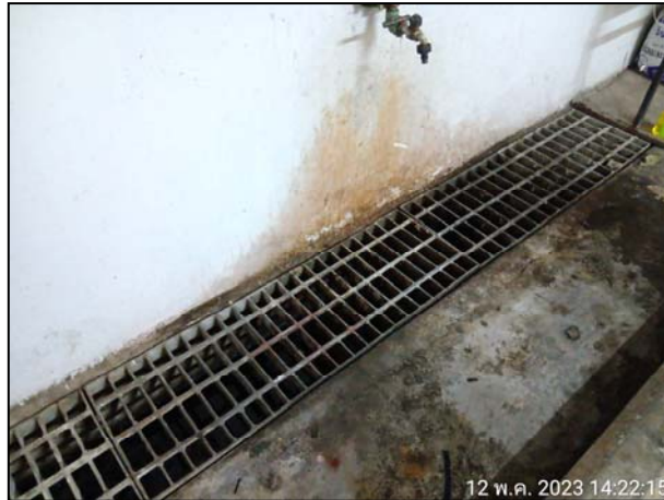
รูปที่ 2.16 ท่อระบายน้ำเสียจากการล้างห้องพักขยะ
