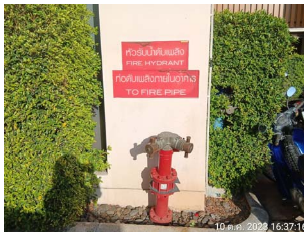
รูปที่ 2.31 หัวรับน้ำดับเพลิงภายนอกอาคาร
