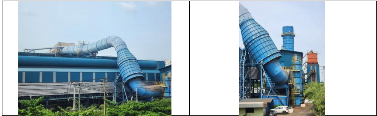
รูปที่ ๗.๗ ระบบบำบัดมลพิษทางอากาศ แบบถุงกรอง (Bag Filter)
