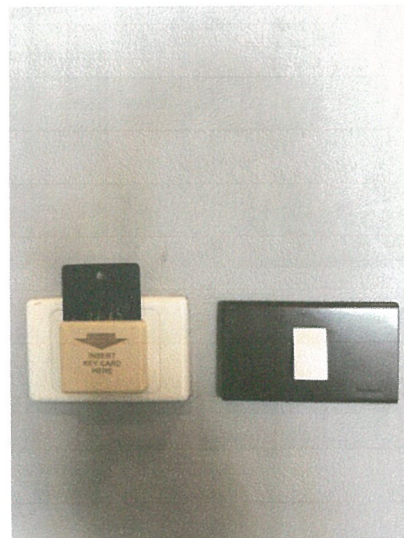
รูปภาพที่ 2.33 ระบบคีย์การ์ด (KEY CARD)
