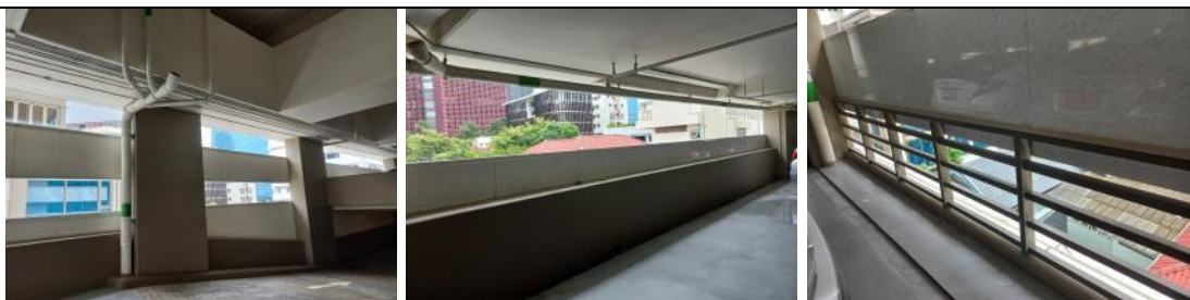
รูปที่ ๗7.5 ช่องระบายอากาศบริเวณพื้นที่จอดรถ
