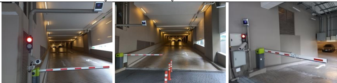
รูปที่ ผ7.13 ระบบไม้กั้นรถอัตโนมัติแบบบลูทูธ (Bluetooth Barrier Gate)
