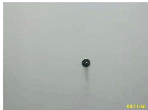
หัวกระจายน้ำดับเพลิงอัตโนมัติ (Sprinkler System)
