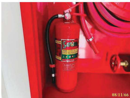
ถังดับเพลิงเคมีแบบมือถือชนิด ABC
