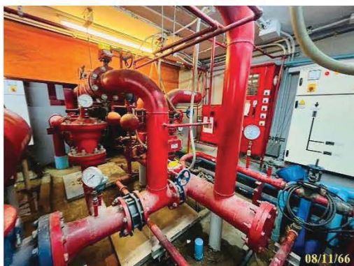
ระบบสำรองน้ำดับเพลิง และจ่ายน้ำดับเพลิง
