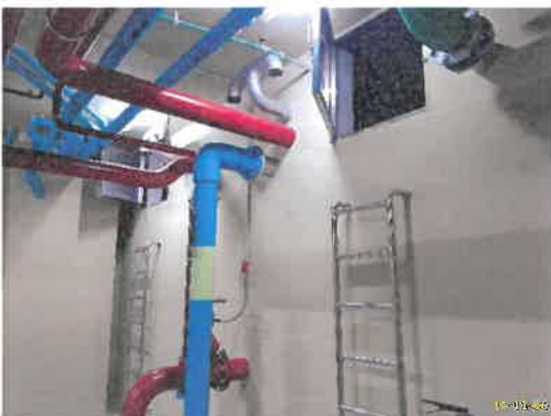
ถังเก็บน้ำสำรองเพื่อการดับเพลิงชั้น 28M อาคาร A
