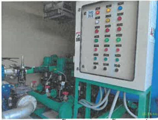
ปั๊ม และถังเก็บน้ำสำรองเพื่อการอุปโภคและบริโภค ชั้นดาดฟ้า อาคาร B
