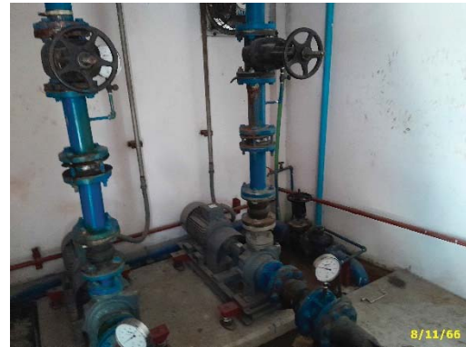
เครื่องปั้มน้ำอุปก-บริโภคชั้นใต้ดิน
