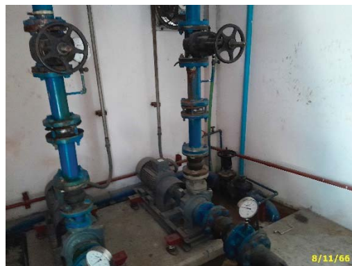
เครื่องปั้มน้ำอุโมงค์-ปริมาตรขึ้นใต้ดิน
