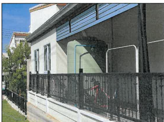
รูปที่ 3.1-11 ถังเก็บน้ำสำรองจำนวน 1 ถัง/แปลง
