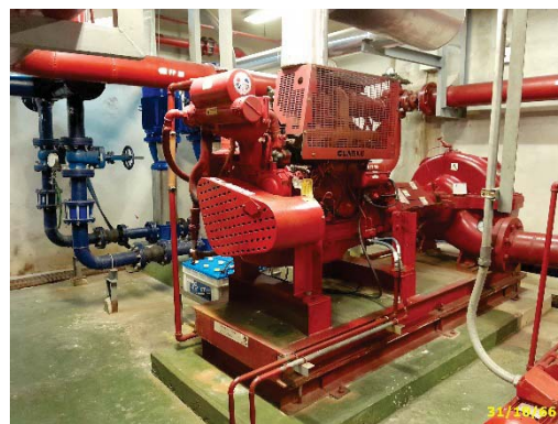
เครื่องสูบน้ำเพื่อการดับเพลิง
