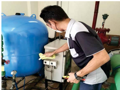
ตรวจเช็คเครื่อง Booster Pump
