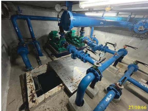
ถังเก็บน้ำใต้ดิน พร้อมเครื่องสูบน้ำ อาคาร C
