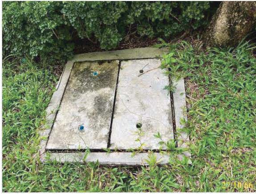
ท่อระบายน้ำและบ่อตรวจสอบการระบายน้ำ
