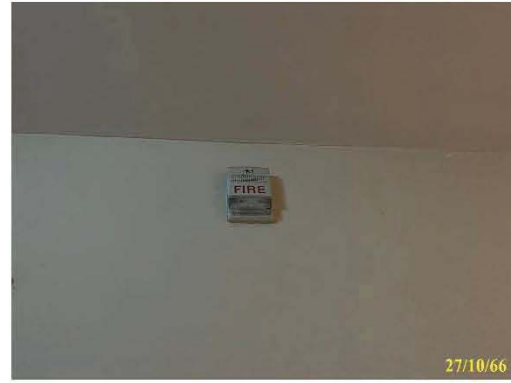
อุปกรณ์ส่งสัญญาณแจ้งเหตุไฟและเสียง
