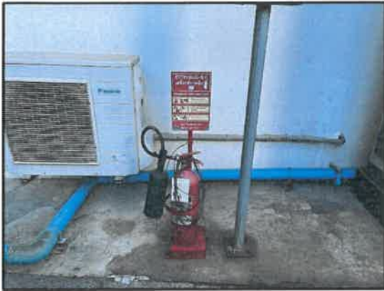
รูปที่ 3-19 ถังดับเพลิงเคมีแบบมือถือ
