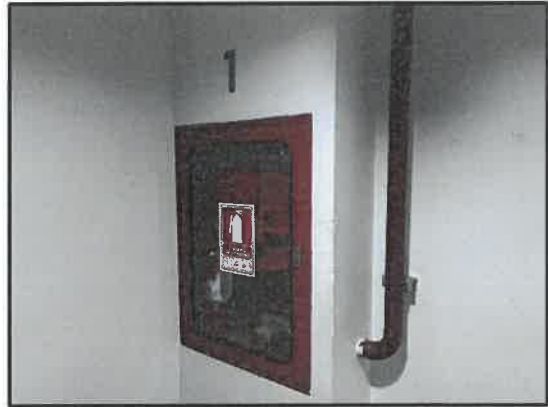
รูปที่ 3-20 ตู้เก็บสายฉีดน้ำดับเพลิงพร้อมอุปกรณ์
