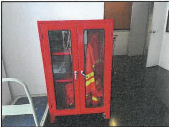
รูปที่ 3-20 ตู้เก็บสายฉีดน้ำดับเพลิงพร้อมอุปกรณ์
