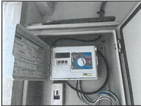
รูปที่ 3-43 ระบบรดน้ำอัตโนมัติของโครงการ
