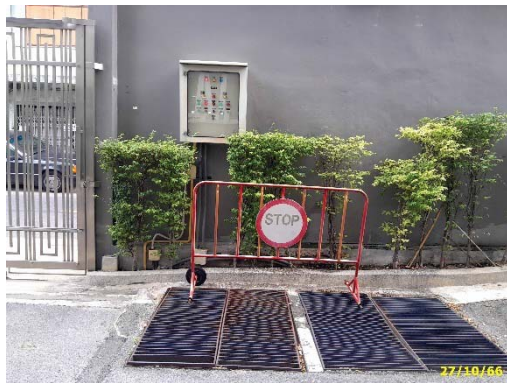
บ่อกักน้ำสุดท้ายก่อนระบายออกนอกโครงการ และ ตู้ควบคุมการทำงานของเครื่องสูบน้ำ
