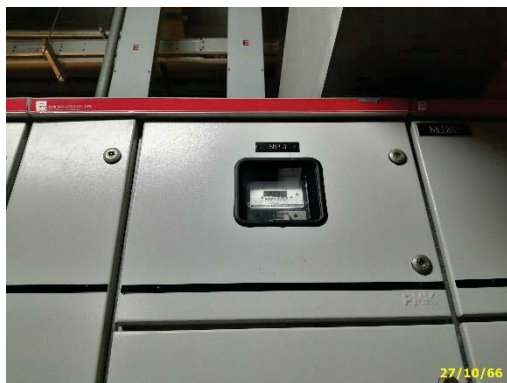
มิเตอร์ไฟฟ้าของระบบบำบัดน้ำเสีย
