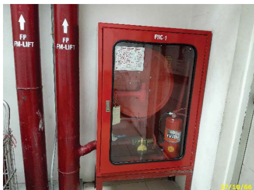
ท่อเย็น และตู้เก็บสายฉีบน้ำดับเพลิง
