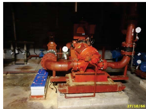
เครื่องสูบน้ำและเครื่องสูบน้ำดับเพลิงชั้นใต้ดิน
