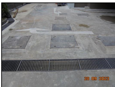
รูปที่ 1-6 ระบบระบายน้ำรอบพื้นที่ก่อสร้าง
