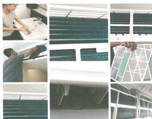
รูปภาพที่ 2.25 ล้างทำความสะอาดแผ่นกรองอากาศ
