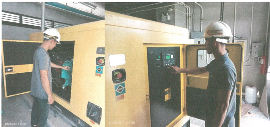
รูปภาพที่ 2.22 การตรวจสอบการทำงานของเครื่องกำเนิดไฟฟ้า
