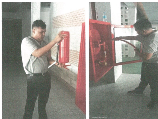
รูปภาพที่ 2.38 การตรวจสอบอุปกรณ์ป้องกันและแจ้งเตือนอัคคีภัย
