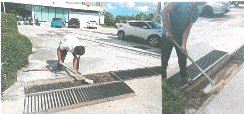
รูปภาพที่ 2.32 การขุดลอกตะกอน
