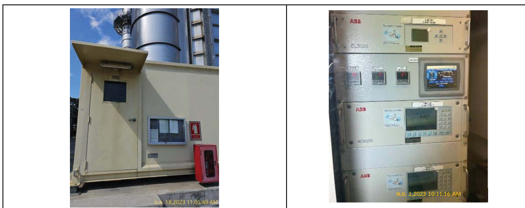
ภาพที่ 3.2-1 : ระบบการตรวจวัดคุณภาพอากาศจากปล่องอย่างต่อเนื่อง (CEMS) ของโครงการ
